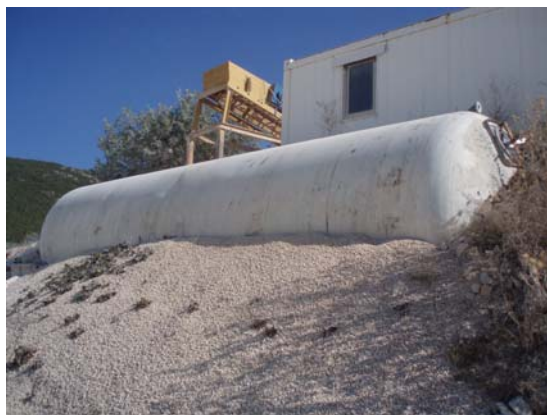
Slika 4.5.1. Cisterna tehnološke vode
