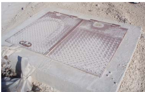
Slika 8.1.2. Hidrant u krugu radilišta
