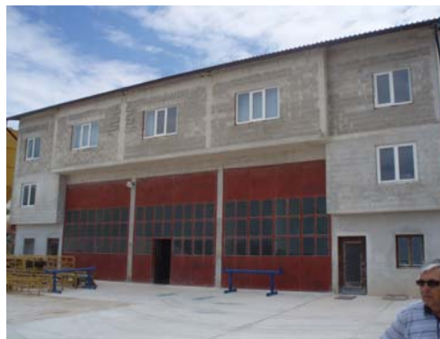
Slika 4.1.3. Radionica, kotlovnica i skladište ulja i maziva
