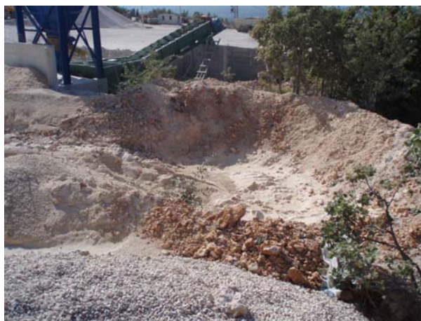
Slika 13.2.2.1. Postojeći taložnik oborinske vode
