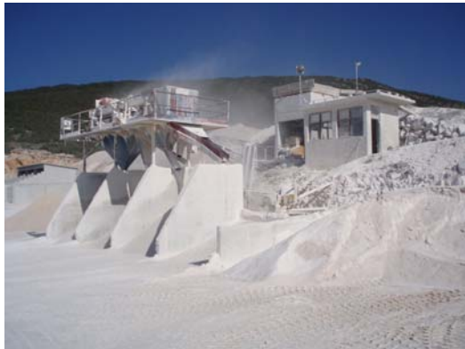
Slika 4.4.2. Postrojenje za drobljenje i sijanje vapnenca
